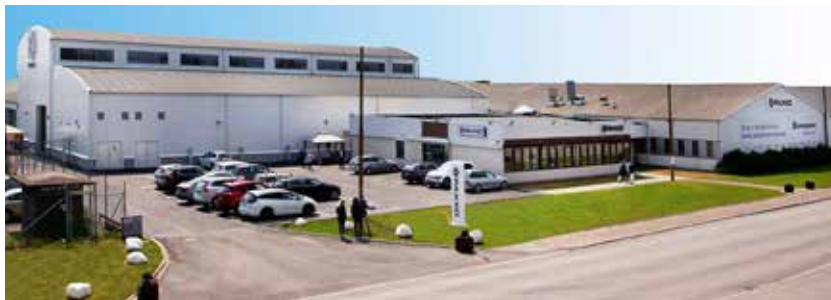
Paxxo AB HQ and production site in Malmö, Sweden.
